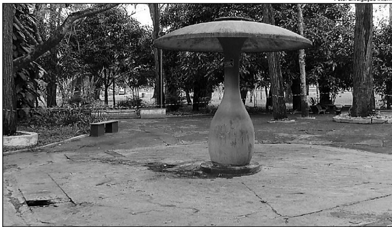
Gêiser do Parque das Águas de Caxambu e o buraco que abriu na estrutura
